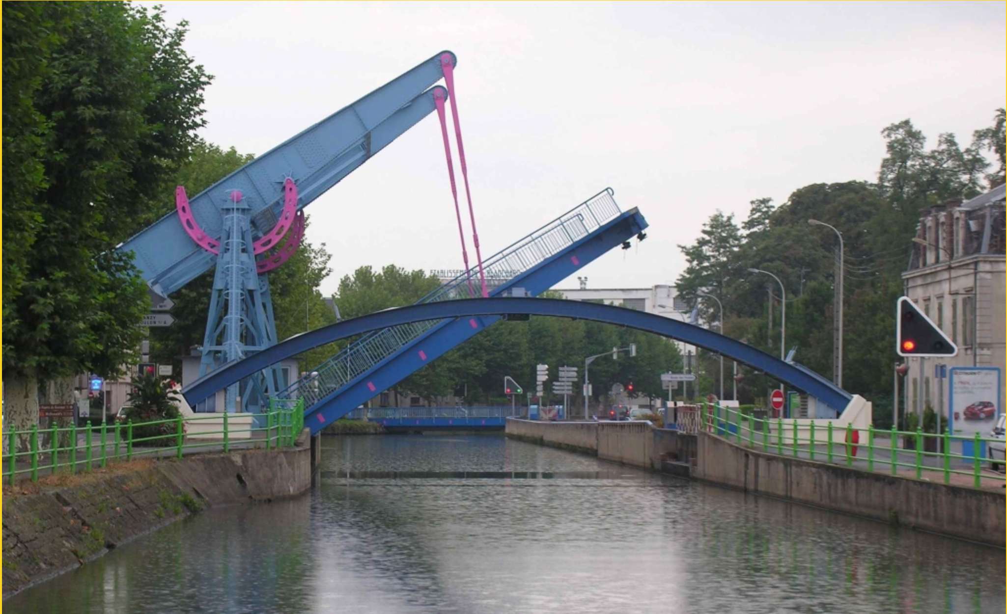
pont de Montceau-les-Mines
