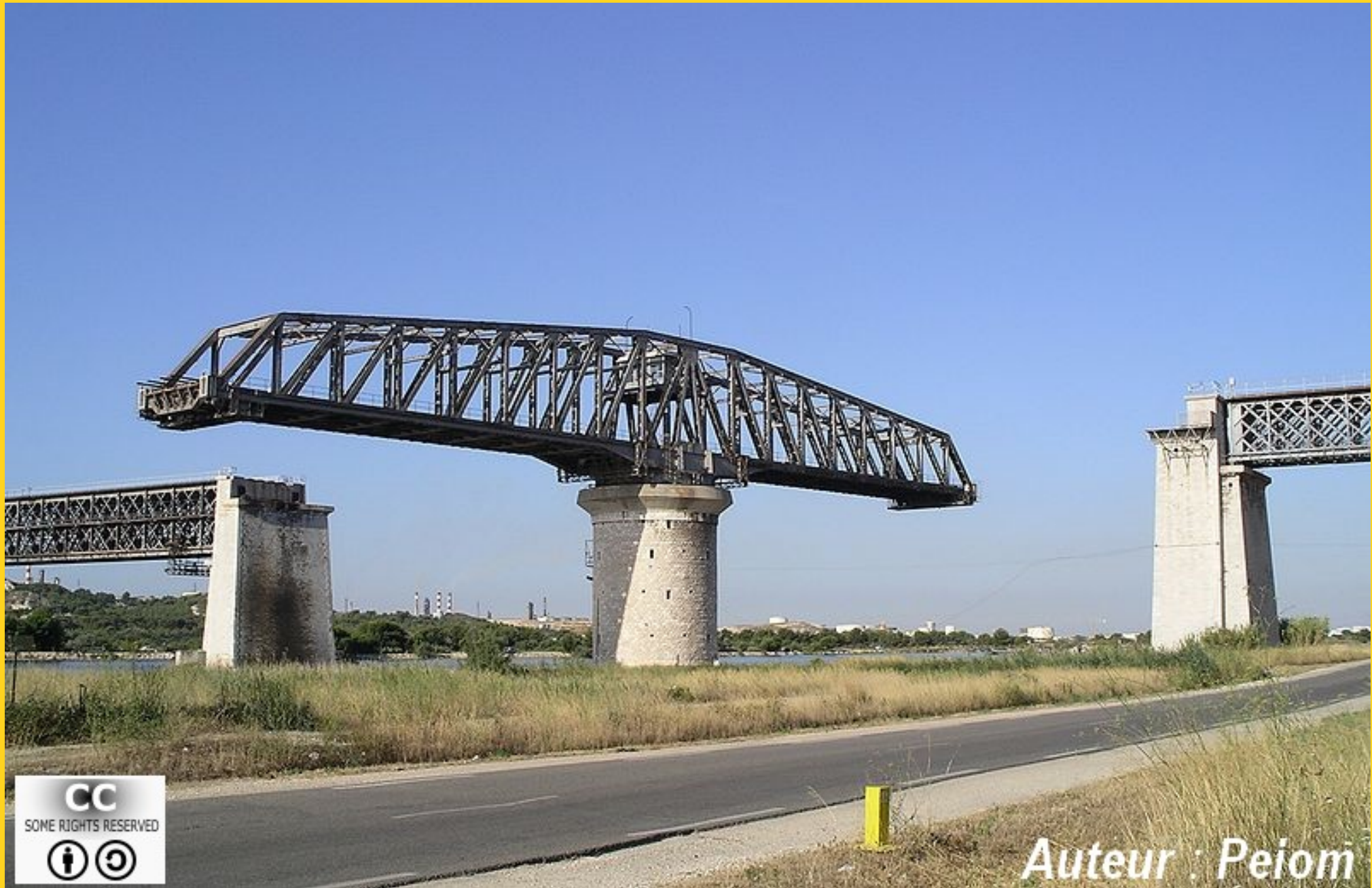
Pont ferroviaire tournant de Caronte, à Martigues (Bouches-du-Rhône - France)
