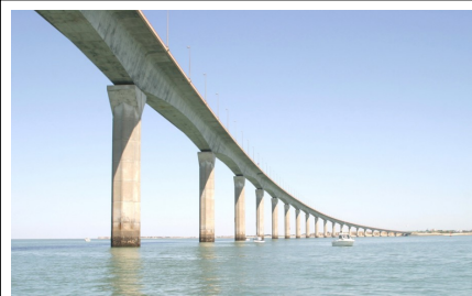
Nom : Pont de l'île de Ré Constructeur : Bouygues Matériaux : béton précontraint Année : 1988
