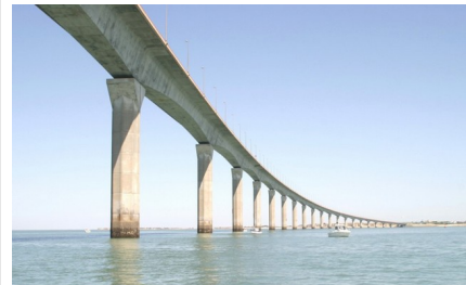
Nom : Pont de l'île de Ré Constructeur : Bouygues Matériaux : béton précontraint Année : 1988
